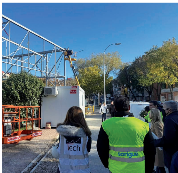
Obras de las instalaciones del IDB Pueblo Nuevo-Ascao
